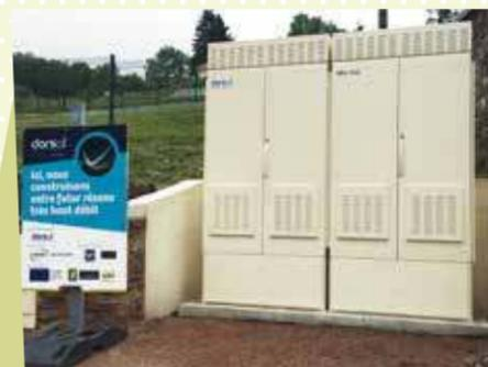
Concrètement, la montée en débit consiste à déployer de la fibre optique jusqu'à un sous répartiteur. De là, repartent les lignes de cuivre classiques (ADSL) jusqu'aux habitations des particuliers. Cette solution permet de « pousser » le débit descendant des lignes raccordées jusqu'à quelques dizaines de Mbits/s.
