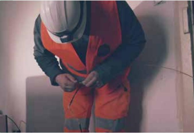
Le raccordement final du logement est la dernière étape avant de pouvoir réellement profiter de la fibre. Il consiste à faire passer un câble de fibre optique en provenance de la rue jusqu'à l'intérieur du logement ou du local professionnel et à installer une prise optique sur laquelle sera branchée la box de l'opérateur. **Généralement, l'installateur suit le même chemin que celui du réseau téléphonique existant.**
