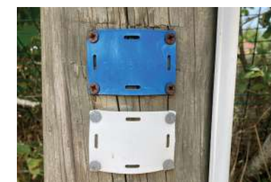
Figure 2 : Poteau avec étiquette bleue, avec ou sans étiquette DORSAL : propriété Orange
