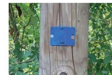
Figure 2 : Poteau avec étiquette bleue, avec ou sans étiquette DORSAL : propriété Orange
